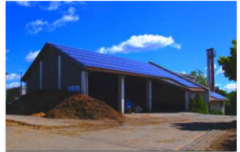
Das Hackschnitzelheizkraftwerk der Biomasse GmbH & Co.KG versorgt das gesamte Dorfzentrum
